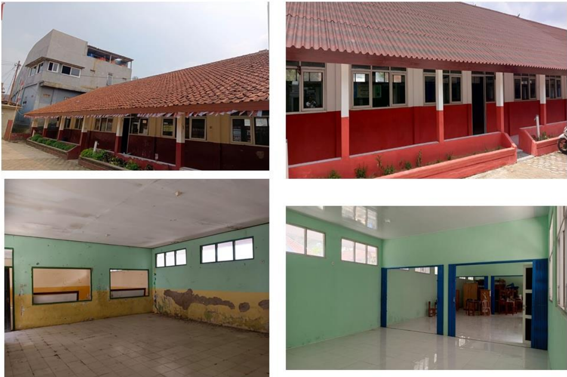
Kondisi fisik bangunan sekolah dasar sebelum dan sesudah pelaksanaan kegiatan Rehabilitasi
